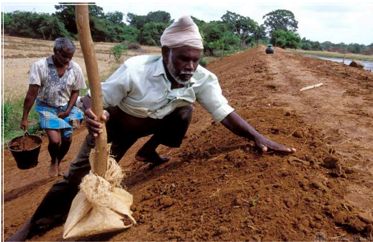
In Sri Lanka, due uomini riparano un argine in cui si è aperta una breccia. Foto: Dominic Sansoni/World Bank
