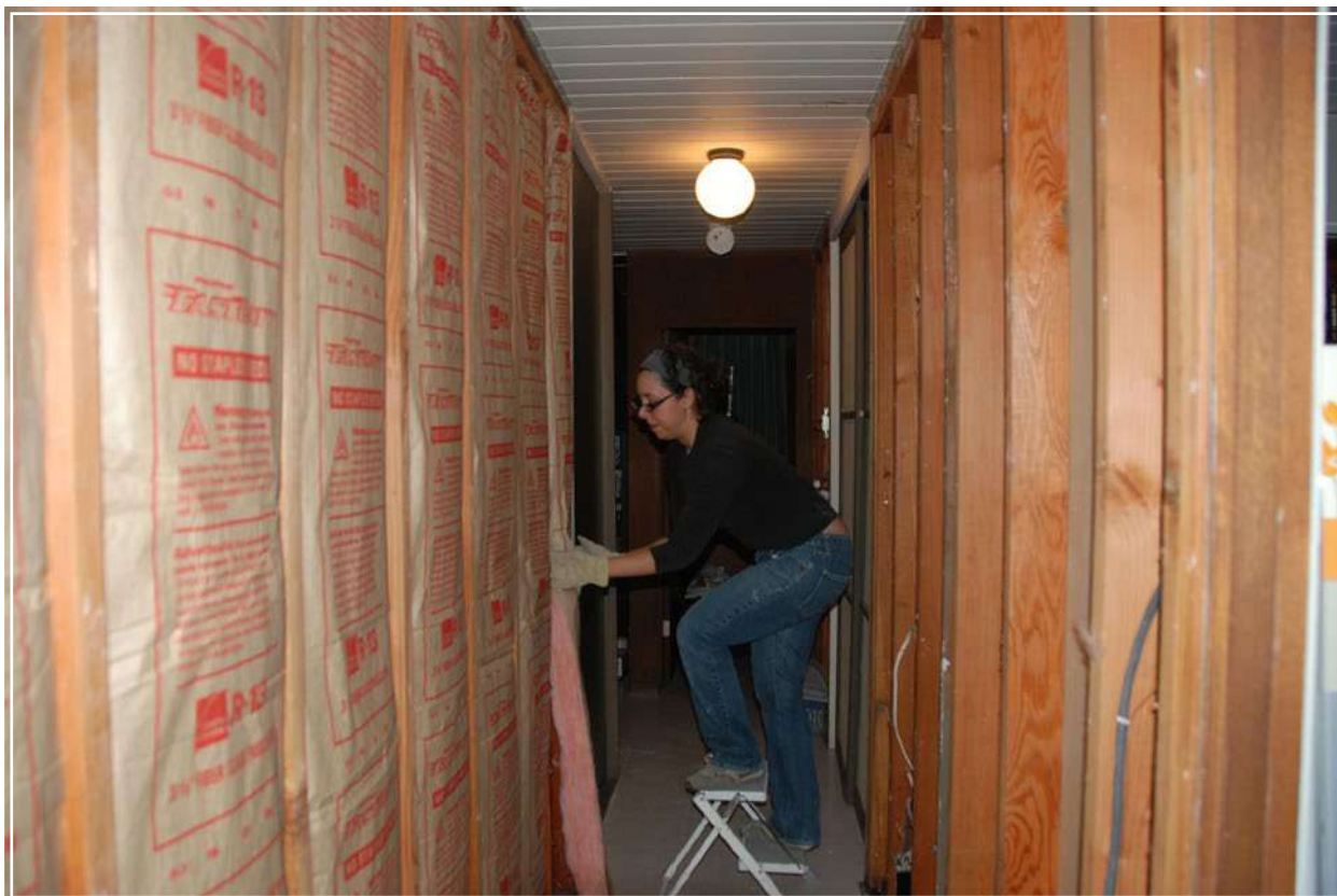
Installazione di pannelli isolanti domestici. Foto: Nick Nguyen
